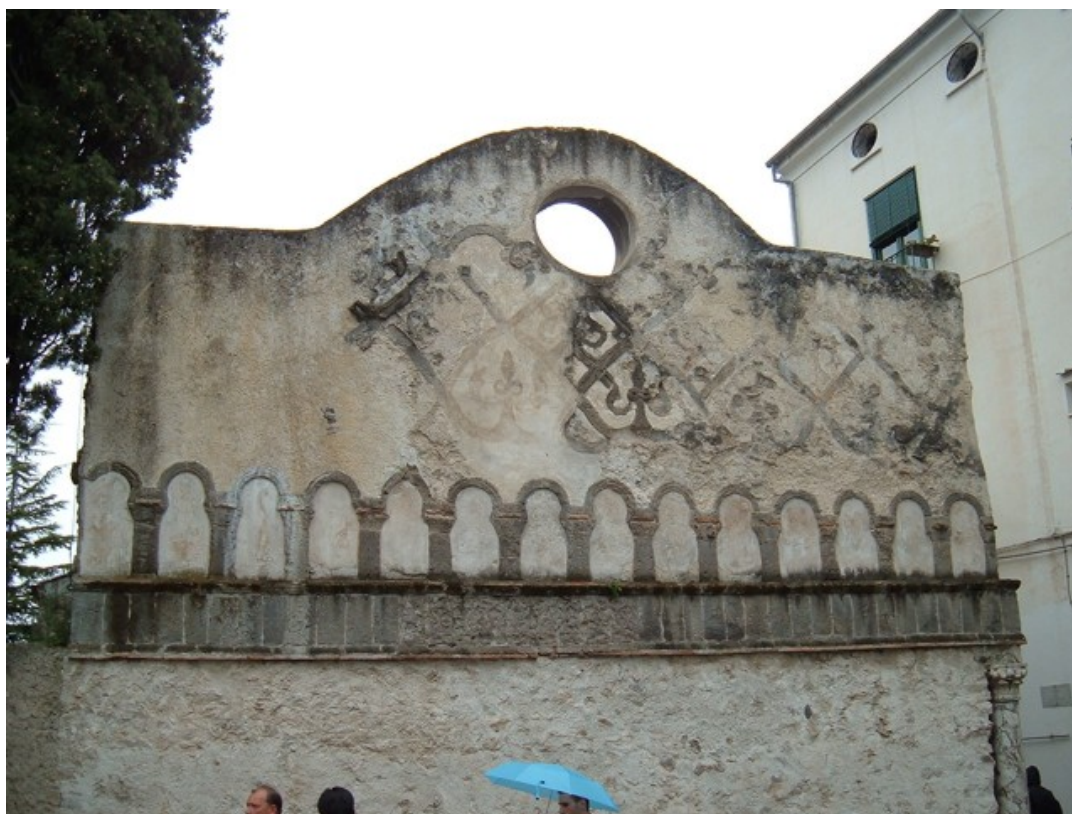
Ravello. Villa Rufolo. Struttura collegata ai muri d'ambito esterni
